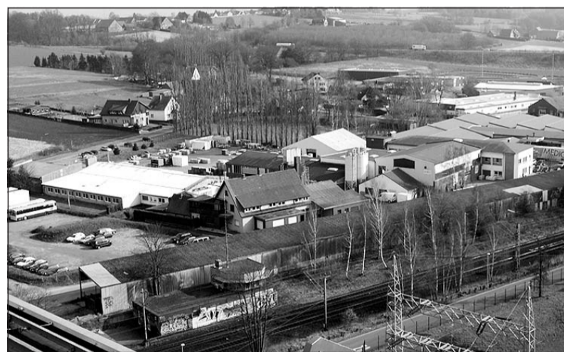
Aus der Vogelperspektive: Die Anlage der Firma Reent Obernolte in Kirchlengern. Fotos (2): Fa. Reent Obernolte
